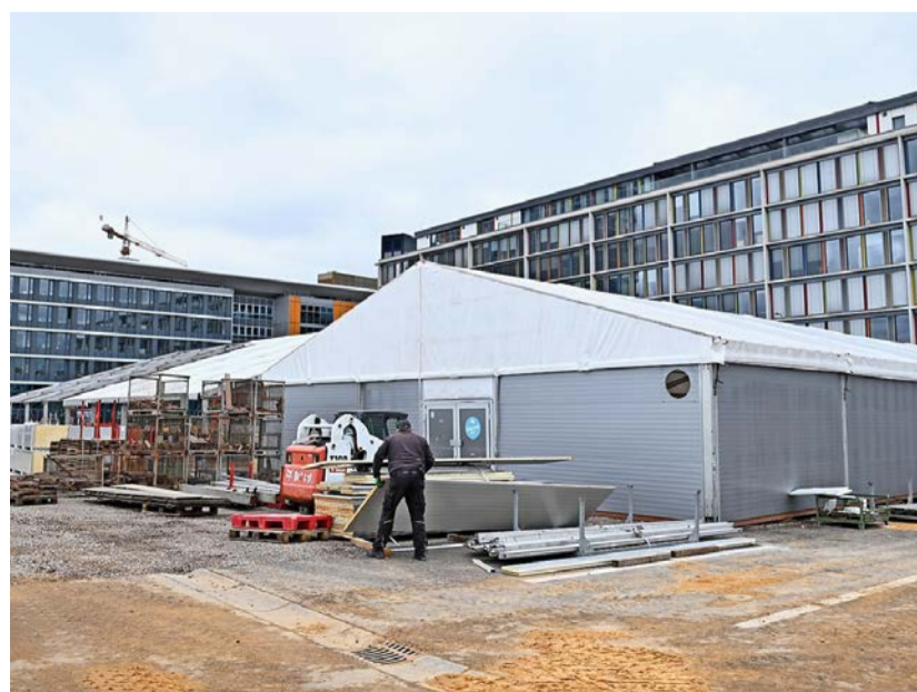
Das „Centre de primo-accueil“ wurde im April errichtet
